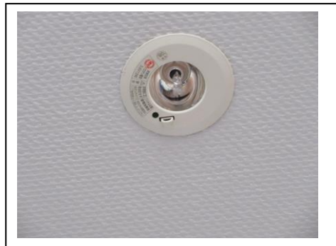
【非常用照明修繕】
