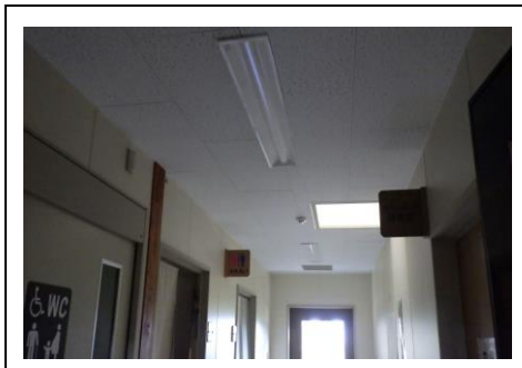
【廊下照明器具 LED 化】
