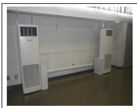
【エアコン改修】
