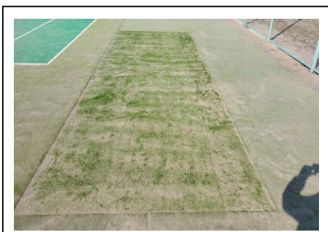
【テニスコート砂入り人工芝補修修繕】
