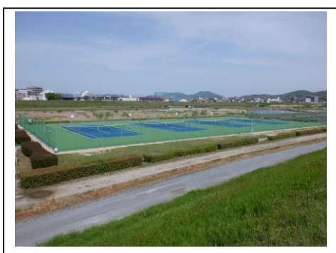
【テニスコートA改修工事】
