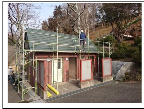
【トイレ屋根改修工事】
