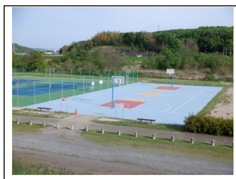
【バスケットコートB改修工事】
