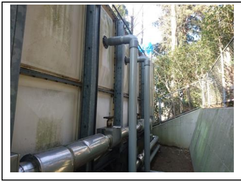
【受水槽給水管漏水修繕】
