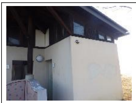
【屋外トイレ照度センサー修繕】
