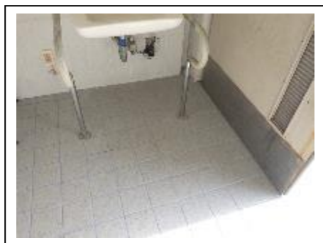
【多目的・身障者トイレ扉・床等修繕】
