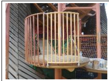
【大型遊具デッキ安全柵修繕】
