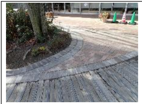
【園路不陸修繕】
