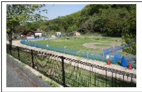
【ふれあい広場フェンス及びベンチ設置】
