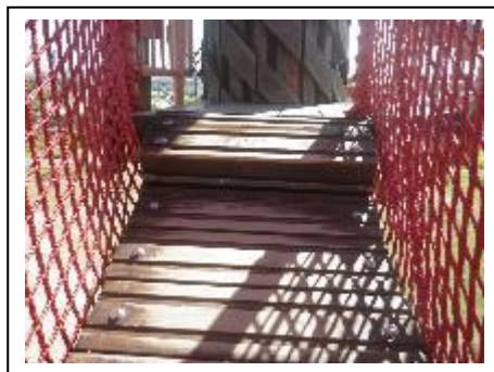
【大型舟形遊具吊り橋隙間解消修繕】
