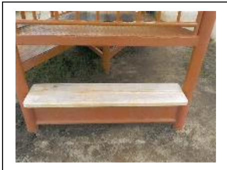
【複合遊具木製テーブル修繕】
