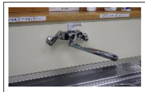
【ボランティア室水栓修繕】
