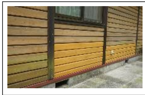
【センター劣化壁等修繕】
