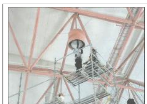
【水銀灯取替修繕】
