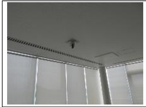
【談話ホール 監視カメラ修繕】
