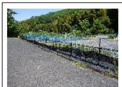
【ロープ柵改修（獣害対策フェンスへの更新）】
