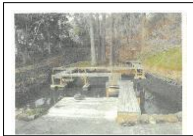
【ラクウショウ池八つ橋修繕】
