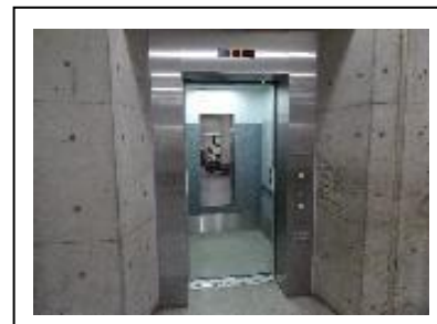
【体育館エレベーター変圧器・基盤他取替修繕】
