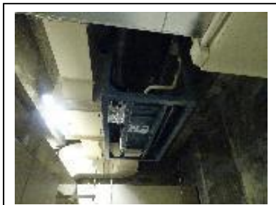
【体育館給排気ファン改修工事】
