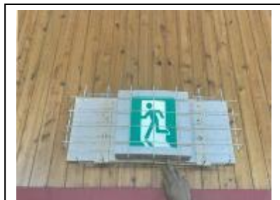
【誘導灯交換修繕】
