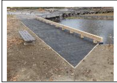
【木道デッキ部（枕木）修繕】
